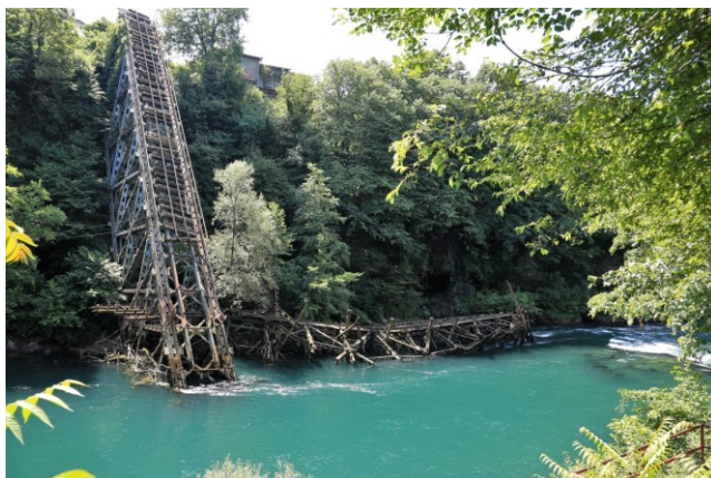
Porušeni most z Bitke na Neretvi v Jablanici
